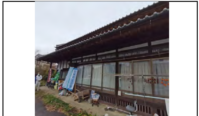
写真番号 2 調査場所 西建物外観
