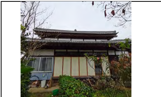
写真番号 3 調査場所 北建物外観
