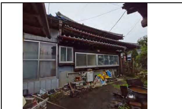
写真番号 5 調査場所 南側サッシ廻り
