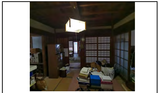
写真番号 24 部屋名 10畳B 状況×モ 作業風景
