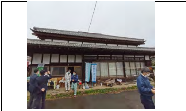
写真番号 1 調査場所 南建物外観
