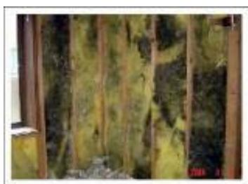
写真5-1-4 壁断熱材周辺部材
