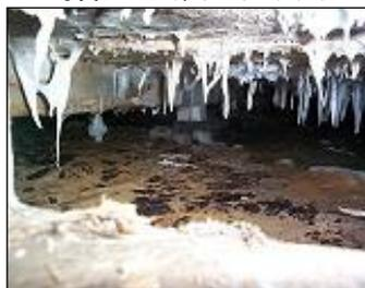
写真5-1-3 壁断熱材のカビ
