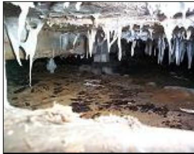
このナミダダケは、北海道では最も警戒しなくてはならない腐朽菌の一つだそうで、その腐朽力は、極めて強く、木材の繊維質を分解しその部分に水を排出し、被害部分は、まるで涙を流しているように見えることで、その名前が付いたそうです。
