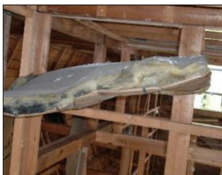
写真4-4-3 築10年目の住宅の壁断熱材(黒い部分は、カビです)
