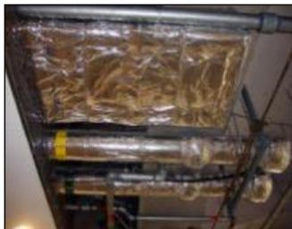
写真11-2-2 京都駅での露出配管カバー拡大
